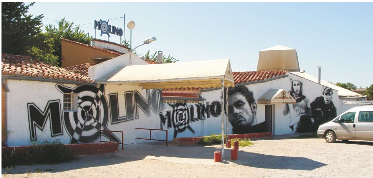
Fachada del local [medidas: +3m. x 20m.]
