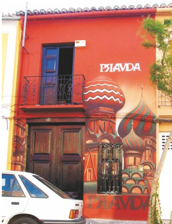
Fachada del local [medidas: 4m. x 3m.]
