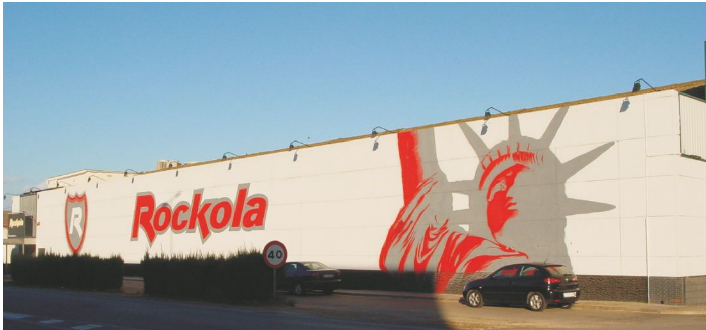
Fachada del local [medidas: 6m. x 36m.]
